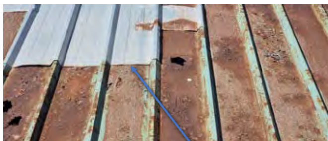
Obr. č. 3 – Nápojení nové plechové krytiny na původní – dokonale proti vodě
