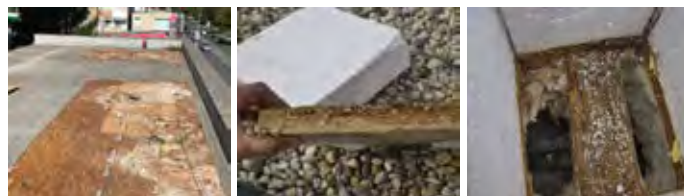
Obr. 1 Použitie OSB dosky a jej degradácia: vľavo spôsobená kondenzáciou na spodnom povrchu povlakovej krytiny [6], v strede a vpravo zabudovaná v skladbe medzi tepelnými izoláciami
