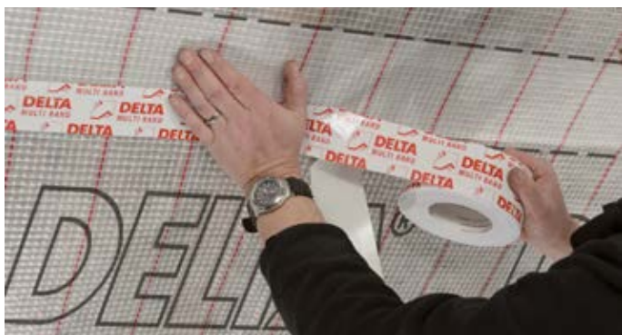
Obr. 4: Vzájomne zlepenie presahov parozábrany musí byť zlepené páskou, ktorá vytvára trvalo vzduchotesný spoj podľa DIN 4108-11.
