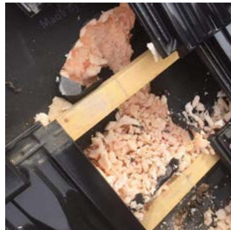
Obr. č. 2 - rozkousaná stříkaná PU pěna
