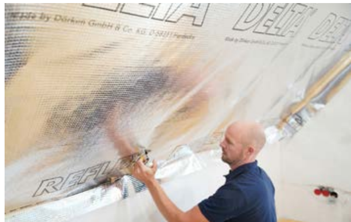
Obr. 3: Kotvenie parozábrany prebieha napr. pomocou sponkovačky do drevenej podkonštrukcie. Medzi parozábranou a vnútorným obkladom (napr. sadrokartónom) je potrebné vytvorenie inštaláčnej medzery pre odraz sálavého tepla do interiéru a umiestnenie elektroinštalácie bez perforovania parozábrany.
