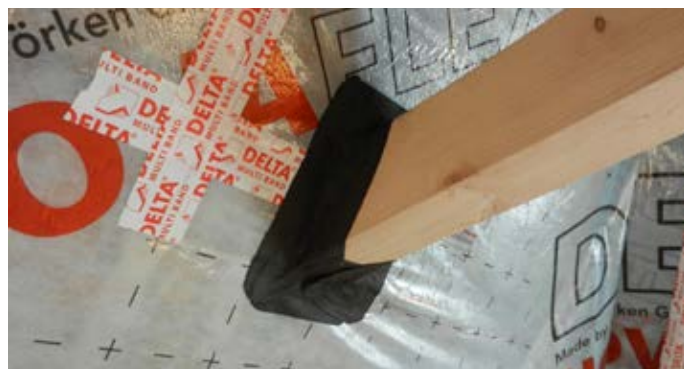
Obr. 6: Pre správne fungovanie parozábrany musia byť všetky prestupy vzduchotesne napojené. V komplikovaných detailoch je vhodné použitie pružnej pásky DELTA®-FLEXX BAND
