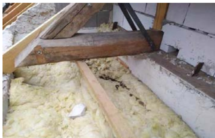
Obr. č. 4 - vykousaná stříkaná PU pěna
