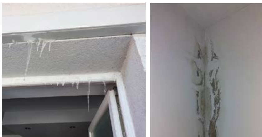
Obr. 1 Voda vytekajúca zo zateplňovacieho systému tvoriaca v zime cencúle a prejavy zatekania v interiéri, pričom následkom vlhkých povrchov je tvorba plesní [1]
