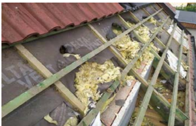
Obr. č. 3 - rozkousaná minerální izolace
