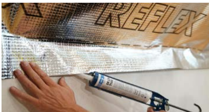
Obr. 5: Aj na štítové a obvodové murivo musí byť parozábrana vzduchotesne nalepená a to tak, aby spoj bol trvalo pružný a vzduchotesne funkčný podľa DIN 4108-11.
